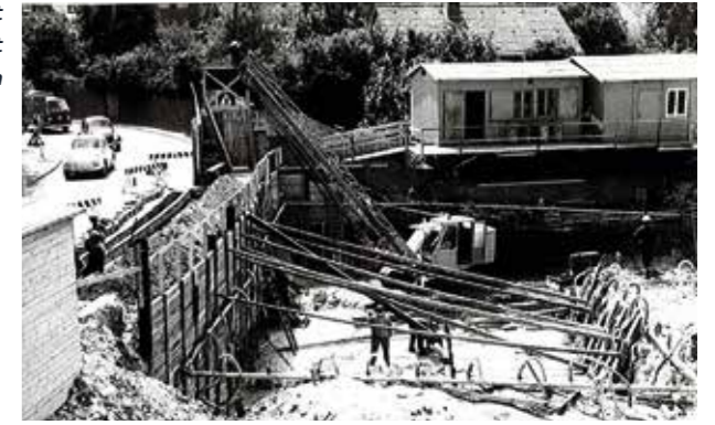
Das größte Bauprojekt der Nachkriegszeit begann in Uelzen
