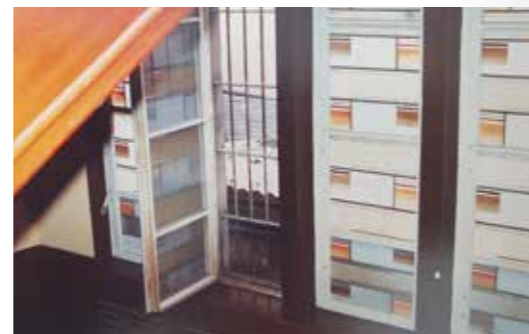
Die alten, handgemalten Fenster im Bauhaus-Stil sind noch heute eine Besonderheit des Hauses
