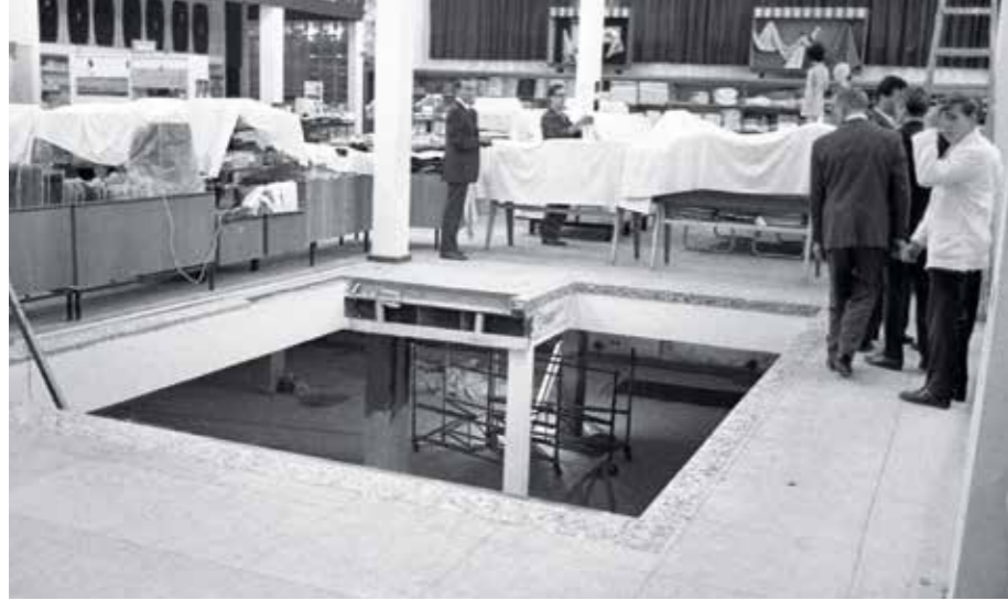
Im Elmshorner Haus wurde 1968 die erste Rolltreppe im Kreis Pinneberg eingebaut
