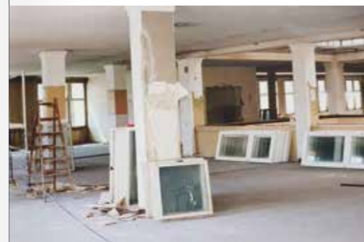
Nach dem Rückkauf des Stendaler Hauses wurde ein umfangreicher Umbau gestartet
