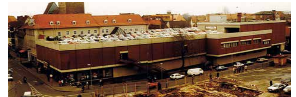
Der großzügige Neubau in Uelzen im Beton-Stil der 70er Jahre
